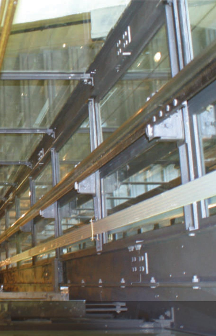
**La société a conçu une ligne de self structures d'appui, ce qui permet l'installation d'ascenseurs extérieurs au bâtiment en cas d'absence d'un compartiment dédié.**
